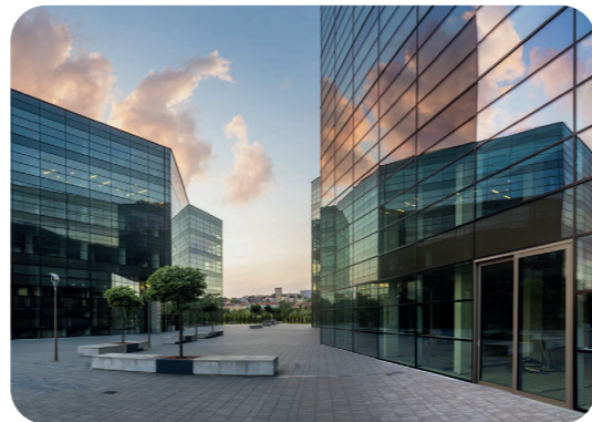
Die Funktionalität der EK-Schlösser kommt in Gebäudemanagementsystemen moderner Bürokomplexe zum Einsatz.
